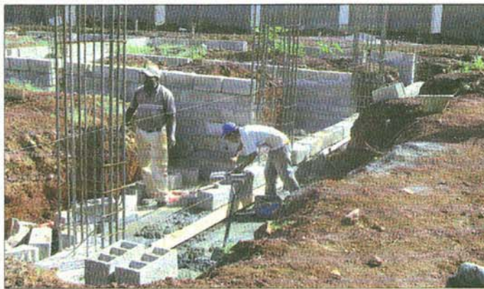
Le bâtiment, qui abritera le Resource and Training Centre (projet phare du MPRB), en construction à Cité Roche-Bois
