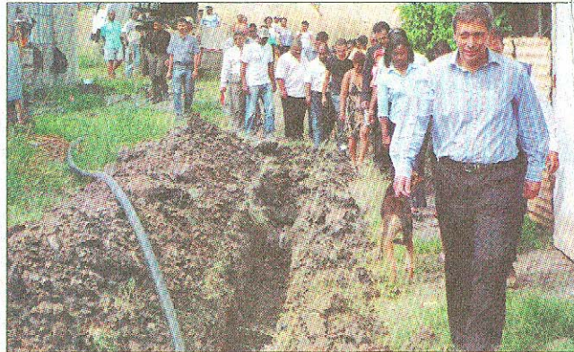
Xavier Duval s'assurant de la progression des travaux.
